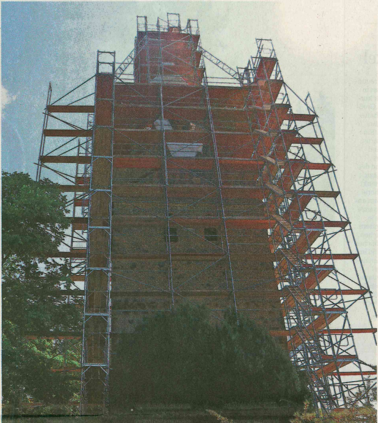
Der eingerüstete Kirchturm in Dennewitz. Die Arbeiten zu seiner Rettung laufen.
