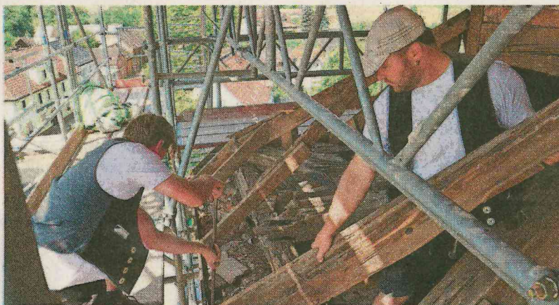
Zimmerleute bei der Arbeit am Dach des Dennewitzer Kirchturmes.
