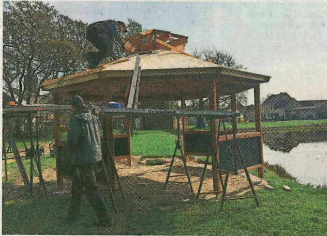
Bau der neuen Schutzhütte am Dorfteich in Oehna in der Gemeinde Niedergörsdorf.
