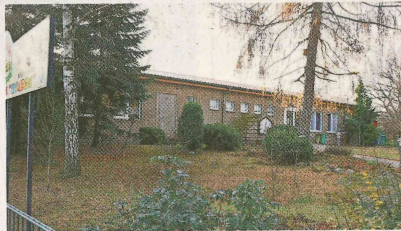
Die Kita in Hennickendorf soll energetisch saniert werden. FOTO: MARGRIT HAHN
