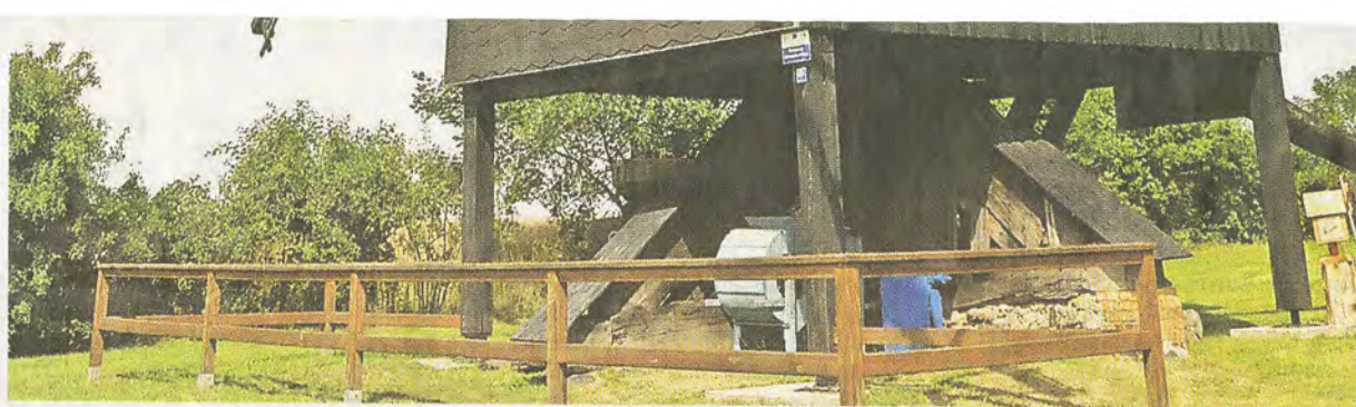
Die Bockwindmühle in Gölsdorf wurde Stück für Stück rekonstruiert.
