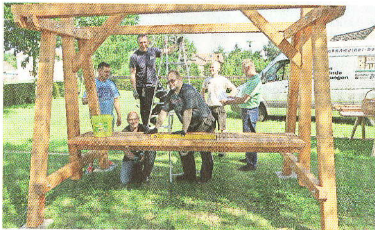
Vereinsmitglieder, Dorfbewohner und die Luckenwalder Bautischler bauten gemeinsam die Sitzraufe auf dem Kirchplatz zusammen. FOTO: KRÜGER
