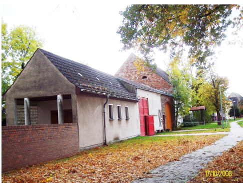
Ist-Zustand bei Antragstellung
